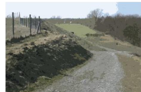
Impressie zicht vanop talud
