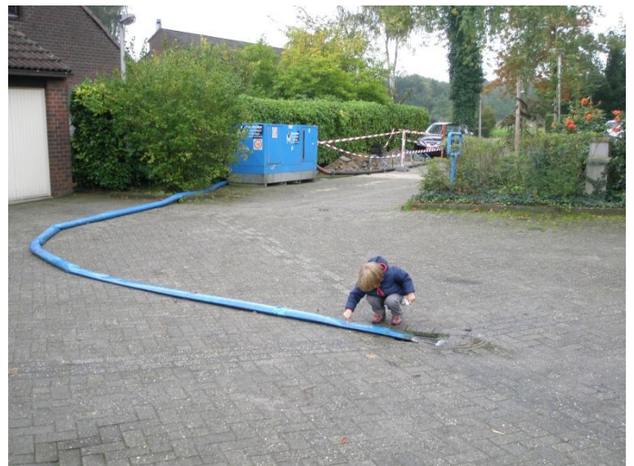
Bemaling en herstellingswerken van verzakkingen, veroorzaakt door problemen met de riolering. Foto overgenomen 4 uit presentatie buurtbewoners.
